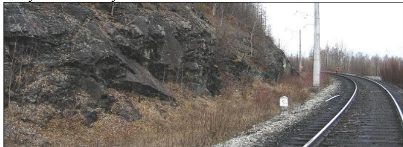
Рисунок 8 – Полувыемка на железной дороге
