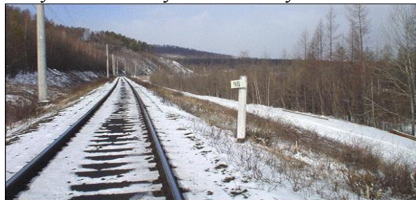
Рисунок 10 – Полунасыпь-полувыемка на железной дороге
