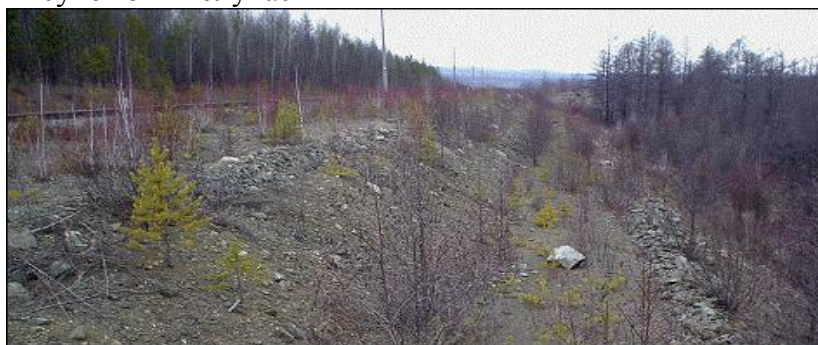
Рисунок 6 – Полунасыпь на железной дороге
